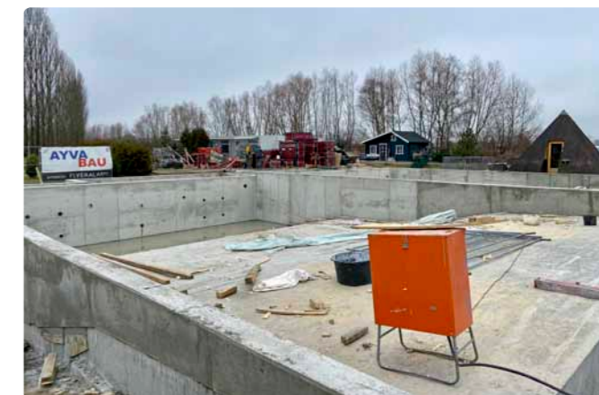
Großbaustelle: Hier entstehen zwei geräumige neue Teiche. Nach Fertigstellung werden sie ein artgerechtes Zuhause für über 300 Wasserschildkröten bieten.
